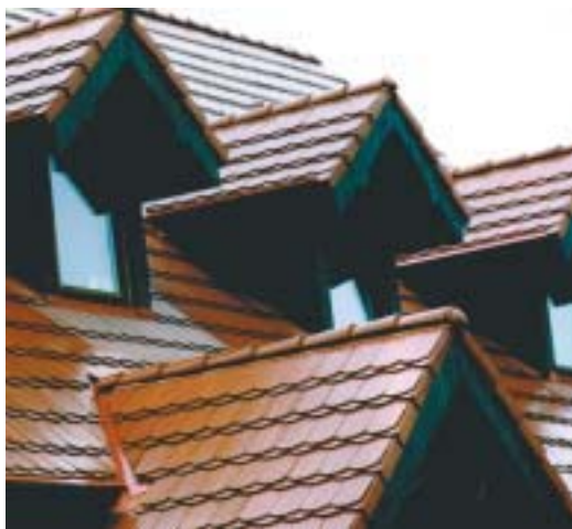
Dach kryty karpiówką (fot. Jopek)
