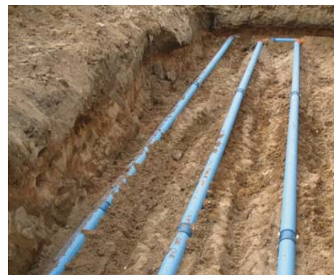
▲ Przeponowy wymiennik ciepła to rury ułożone w wykopie w ziemi. Rurami tymi płynie powietrze
