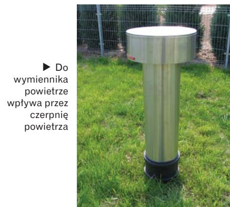
▲ Przeponowy wymiennik ciepła to rury ułożone w wykopie w ziemi. Rurami tymi płynie powietrze
