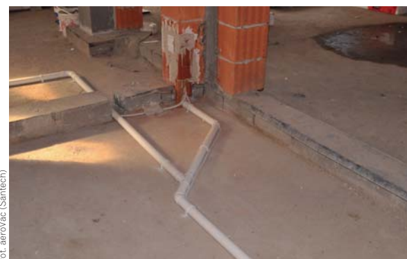
▲ Rury ssące prowadzi się wzdłuż linii prostych – powinny mieć jak najmniej załamań
