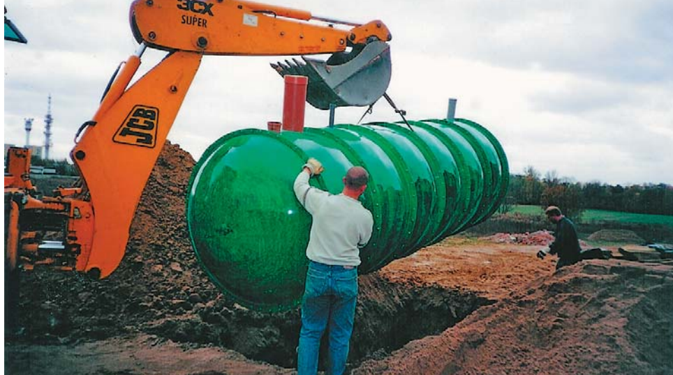
Nawet duży zbiornik z tworzywa sztucznego jest lekki, a więc łatwy w transporcie i montażu
