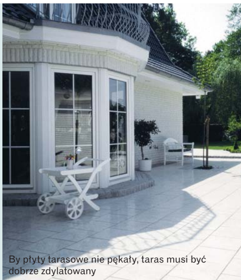
Płytki ceramiczne układane na tarasie muszą być mrozoodporne i antypoślizgowe
