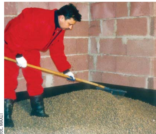
▲ Kruszywo keramzytowe trzeba wysypać na podsypkę piaskową i zagęścić
