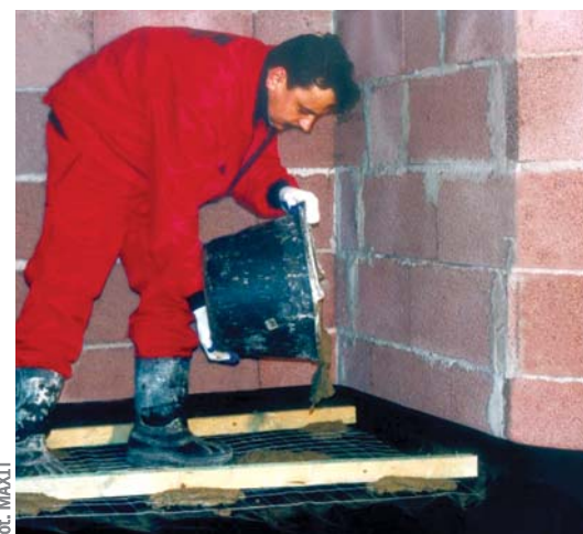
Na keramzytcie układa się folię polietylenową a na niej - siatkę i warstwę wyrównawczą z betonu ▼
