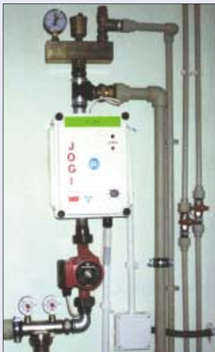
3 Elektrodoowe urządzenie grzewcze „Jogi” (fot. Yox-Pol): ta skrzyneczka o wymiarach 27x21x16 cm wystarcza do ogrzania domu jednorodzinnego o kubaturze do 500 m 3 , a jednocześnie zapewni 600 l ciepłej wody na godzinę; korzysta, oczywiście, z urządzeń dodatkowych zewnętrznych (np. pompa obiegowa, widoczna u dołu po lewej stronie)
