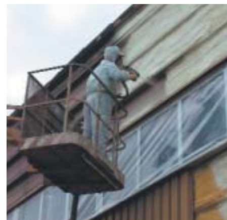
Metoda natryskowa – z zastosowaniem pianki poliuretanowej (Izolacje Pluimers)
