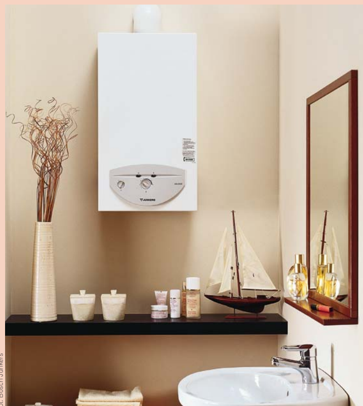
▲ Podgrzewacze gazowe to dodatkowe urządzenia stosowane przeważnie w pomieszczeniach znacznie oddalonych od głównej kotłowni
