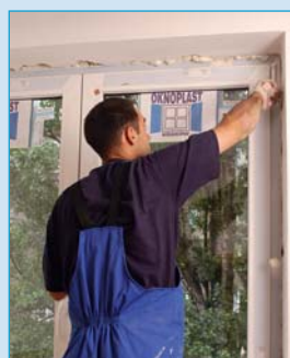
6 Usunięcie nadmiaru pianki montażowej
