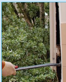
1 Demontaż starych okien
