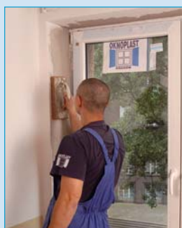
8 Obróbka tynkarska okna
