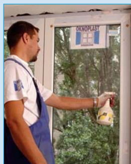
4 Zwilżenie powierzchni roboczej wodą przed wypełnieniem pianką poliuretanową
