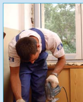
7 Montaż parapetów
