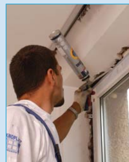
5 Wypełnienie pianką szczeliny między oknem a ścianą
