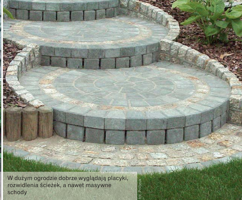
W przypadku kostki betonowej nie ma problemu z odpływem wody deszczowej, która łatwo wsiąka przez szczeliny wypełnione piaskiem
