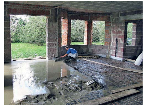
▲ Tworzenie warstwy konstrukcyjnej z betonu
