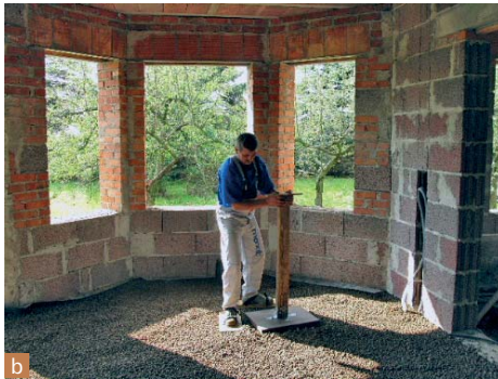
▲ Rozprowadzanie warstwy wyrównującej z podsypki kermazytowej (a) i zagęszczanie keramzytu (b)
