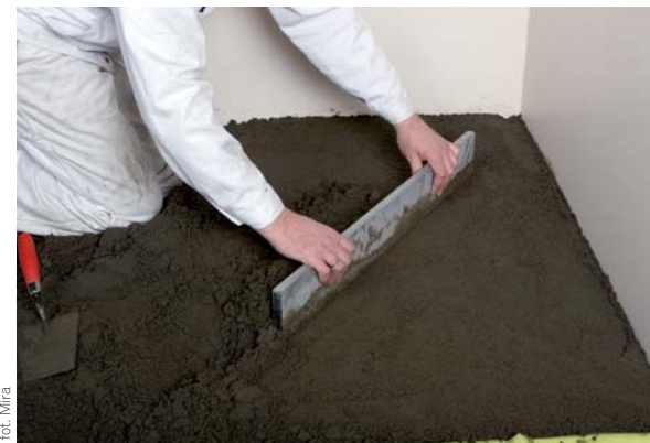
▲ Wykonanie warstwy podkładowej z szybko twardniejącego betonu
