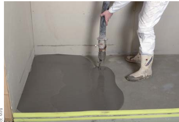
▲ Wyrównywanie betonowej warstwy podkładowej przy użyciu wylewki samopoziomującej
