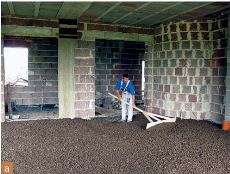
▲ Rozprowadzanie warstwy wyrównującej z podsypki kermazytowej (a) i zagęszczanie keramzytu (b)
