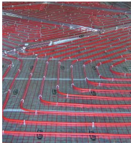
2 Instalacja wodnego ogrzewania podłogowego (fot. Kisan) ▲
