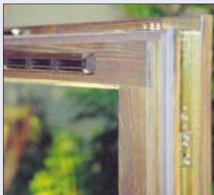
9 Nawiewnik higrosterowany, zamontowany w ramiaku (fot. autorzy)
