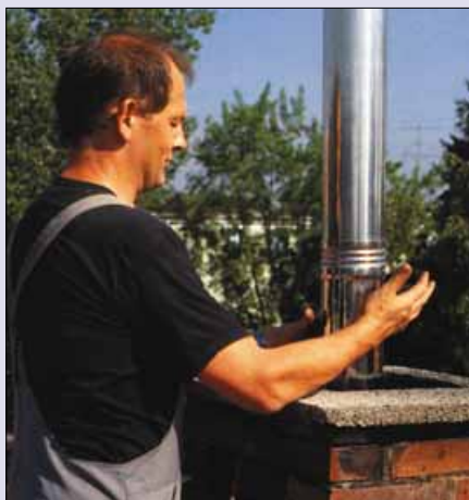
1 Istniejący komin można wyremontować i dostosować do nowoczesnego kotła umieszczając w nim stalowy wkład (fot. Schiedel)
