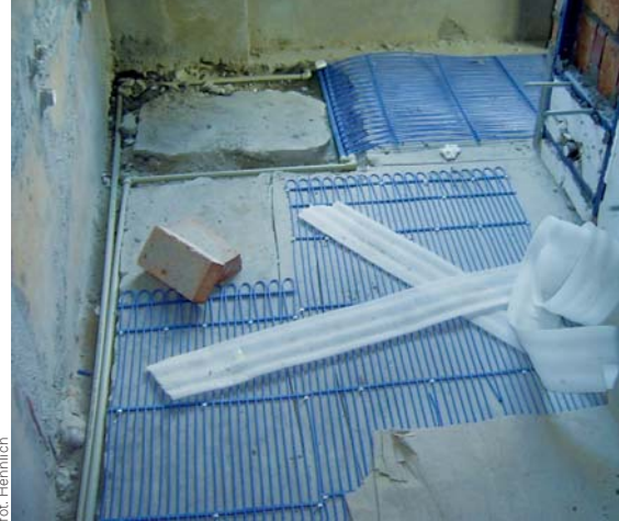
▲ Maty kapilarne wraz z rurkami doprowadzającymi wodę
