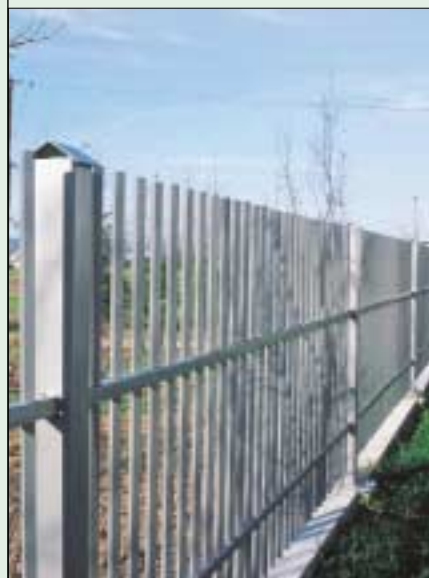
2 Plot z profili stalowych (fot. WIŚNIEWSKI)
