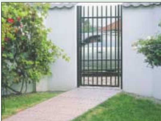
9 Metalowa furtka wstawiona w ogrodzenie murowane z cegieł (fot. WIŚNIEWSKI)
