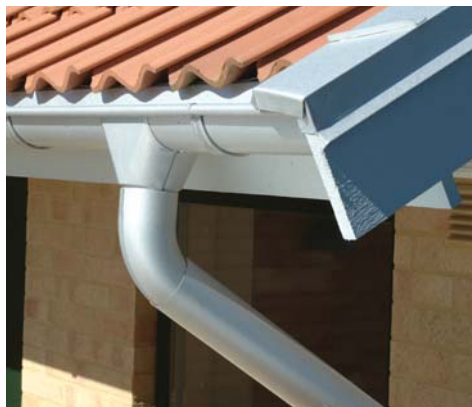
▲ Orynnowanie metalowe ma dużą odporność na zmiany temperatury
