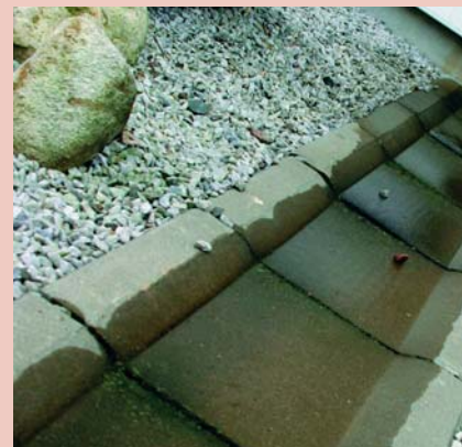
▲ Betonowe korytka pod wylotami rur spustowych kierują wodę z dala od ściany
