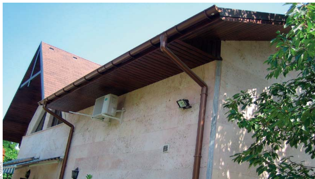
▲ Systemy rynnowe z PVC mają najniższy współczynnik chropowatości ze wszystkich rodzajów orynnowania. Oznacza to, że najłatwiej i najszybciej sływa po nich woda i najtrudniej osadza się w nich brud
