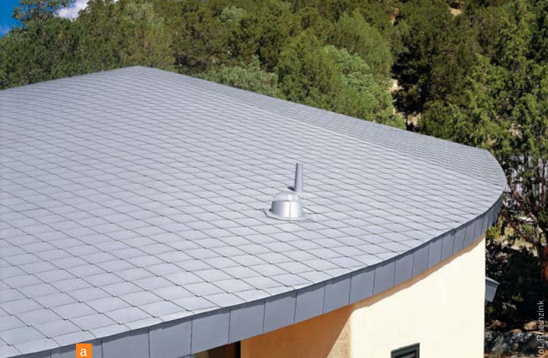
▲ Pokrycia z blachy najlepiej stosować na dachach o prostych kształtach. Można pokrywać nimi dachy o niewielkim kącie nachylenia – blachy płaskie (a) lub te bardzo strome – blachy profilowane (b)
