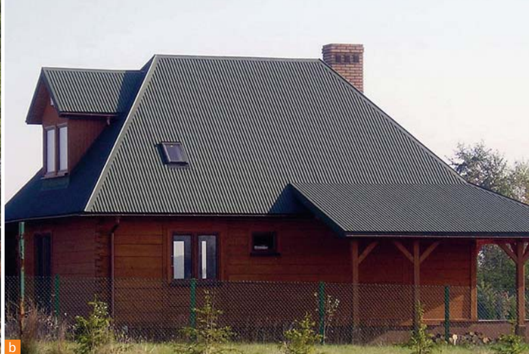
▲ Pokrycia z blachy najlepiej stosować na dachach o prostych kształtach. Można pokrywać nimi dachy o niewielkim kącie nachylenia – blachy płaskie (a) lub te bardzo strome – blachy profilowane (b)
