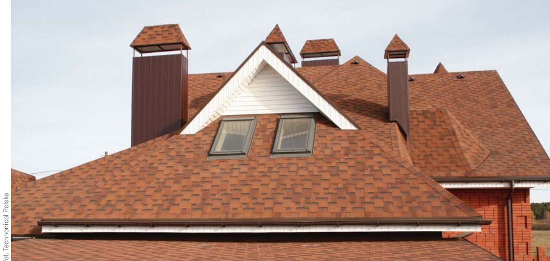
▲ Dach pokryty dachówką bitumiczną. Materiał, ponieważ jest giętki i łatwy do cięcia, świetnie nadaje się do krycia dachów o skomplikowanych kształtach
