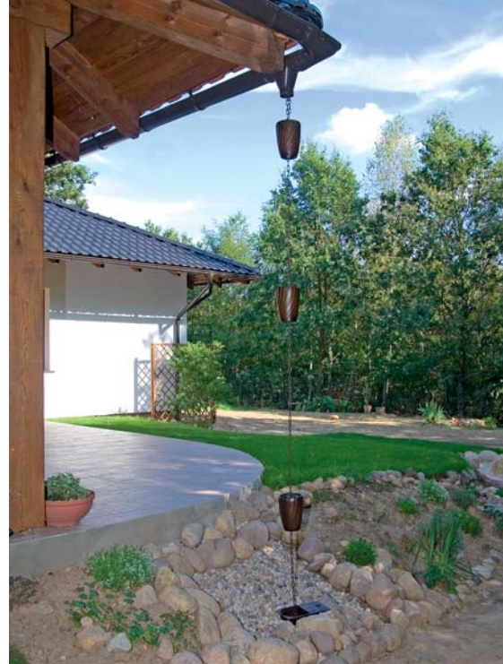
▲ Wodę z rozległego dachu pokrytego dachówką ceramiczną firmy Röben w większości punktów odprowadzają rury spustowe, ale od strony ogrodu gospodarze zamontowali malowniczy tańczuch
