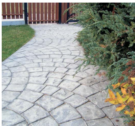
▲ Nawierzchnia z betonu odciskanego może imitować materiały naturalne: nawierzchnię z desek, płyt kamiennych czy z cegły
