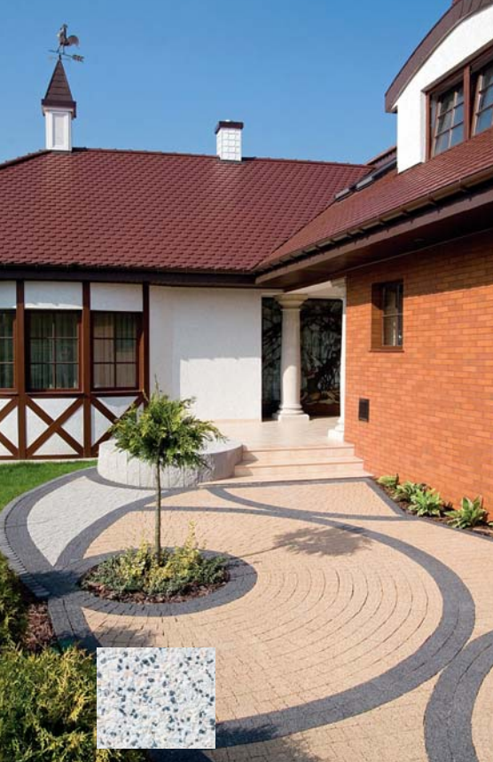
▲ Nawierzchnia z kostki betonowej o powierzchni pfluowanej, w trzech kolorach, odwzorowująca granitową nawierzchnię starych ulic
