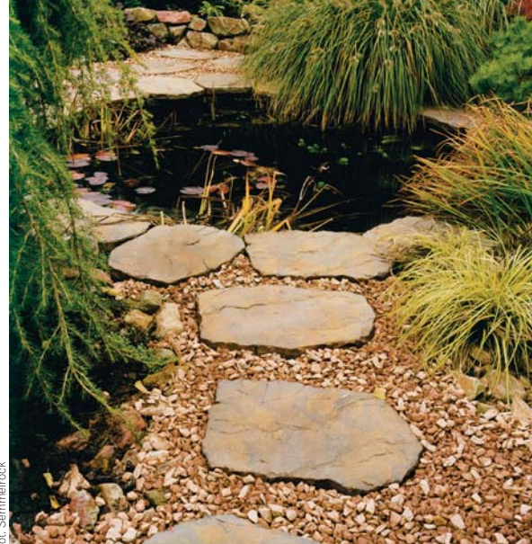
▲ Nawierzchnia z płyt kamiennych nie musi mieć obrzeży. Duże płyty lepiej wyglądają w dużym ogrodzie
