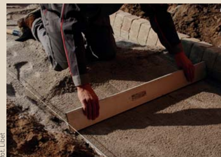
▲ Następną warstwę układa się z piasku (ewentualnie stabilizowanego cementem). Warstwę tę należy wyrównać i utwardzić mechanicznie. Powinna mieć grubość pod ścieżki – ok. 5 cm, podjazd – 5–10 cm
