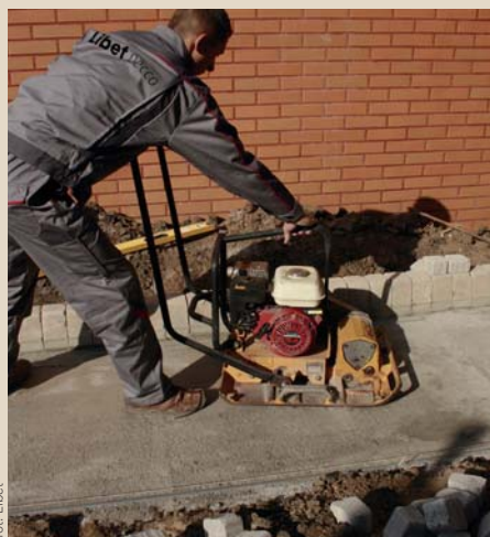
▲ Kolejną czynnością jest rozłożenie na dnie wykopu geowłókniny, a następnie – warstwy podbudowy z grubego kruszywa lub tłuczni, którą stabilizuje się zagęszczarką. Grubość warstwy powinna wynosić pod ścieżki – 10–20 cm, podjazd – 20–30 cm
