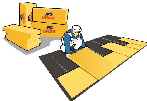
2 Układanie warstwy termoizolacji z płyt URSA XPS
