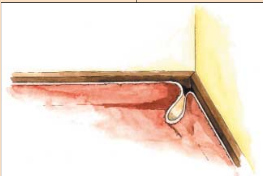
8 Wykładzinę przed przyklejeniem układamy na podłodze z kilkucentymetrowym zakładem na ściany
