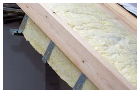
Warstwy wełny mineralnej – między krokiewiami i pod krokiewiami.
