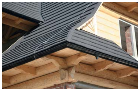
Dachówka gontopodobna już ułożona, czas na okna
