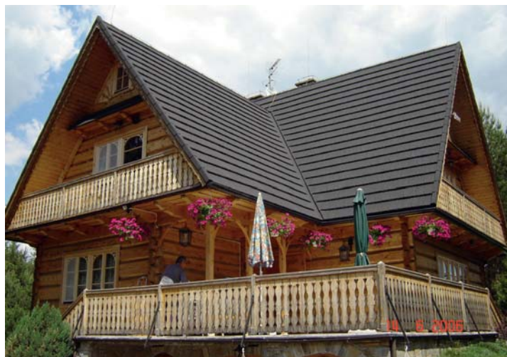
2 tygodnie później – dom pokryty blachą gontopodobną
