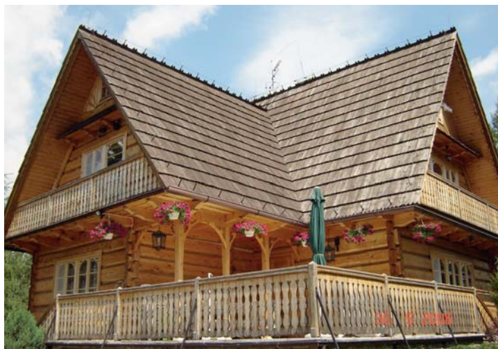
Dom pokryty gontem drewnianym do wymiany
