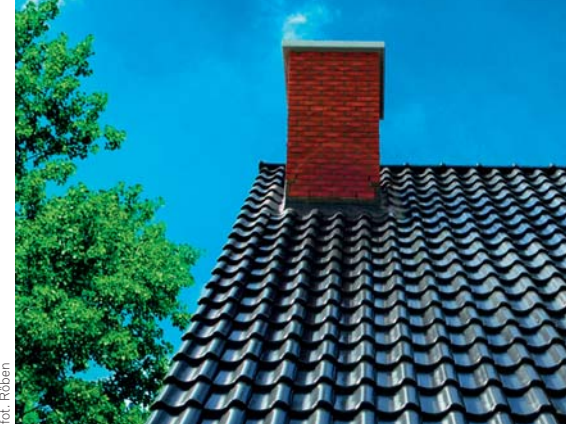
▲ Minimum raz w roku kominarz powinien sprawdzić szczelność i stan techniczny komin
