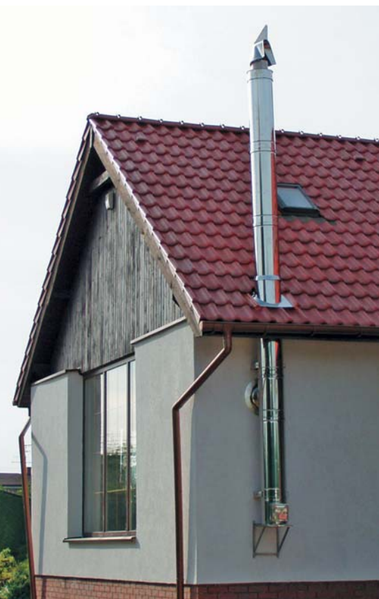
▲ Stalowy komin zewnętrzny
