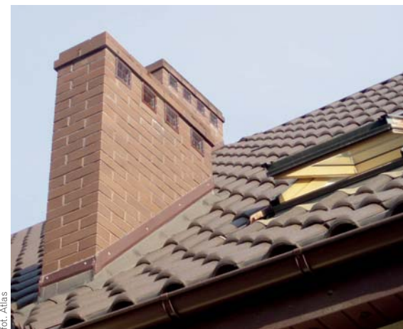
▲ Odnowiony komin wykończony płytkami klinkierowymi
