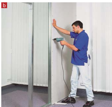
Profile pionowe CW wkłada się najpierw w dolny profil UW, a następnie w górny, ale nie mocuje się ich do profili poziomych (a). Po pokryciu płytami pierwszej strony ściany (b) i ułożeniu w niej instalacji, między profilami układa się izolację akustyczną z wełny mineralnej (c)
