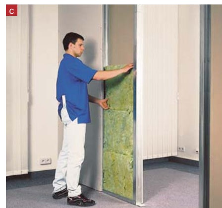
Profile pionowe CW wkłada się najpierw w dolny profil UW, a następnie w górny, ale nie mocuje się ich do profili poziomych (a). Po pokryciu płytami pierwszej strony ściany (b) i ułożeniu w niej instalacji, między profilami układa się izolację akustyczną z wełny mineralnej (c)
