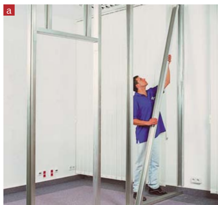
Profile pionowe CW wkłada się najpierw w dolny profil UW, a następnie w górny, ale nie mocuje się ich do profili poziomych (a). Po pokryciu płytami pierwszej strony ściany (b) i ułożeniu w niej instalacji, między profilami układa się izolację akustyczną z wełny mineralnej (c)
