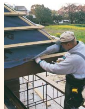
Folia paroprzepuszczalna – warstwa wstępnego krycia uszczelniająca wszystkie rodzaje pokryć dachów skośnych leżące na łąkach (foto. Marma)
