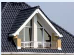
Poddasze użytkowe doświetla się lukarną lub montując okna dachowe (fot. Aluplast)
