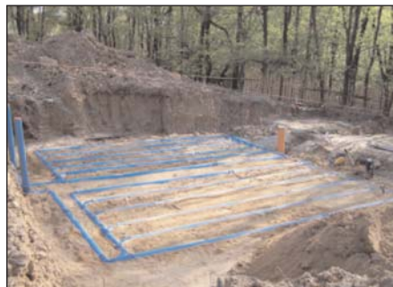
Fot. 6, 7 GWC pod płytą fundamentową
