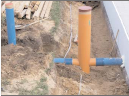
Fot. 3 Studnia oraz wyjście do czepni
