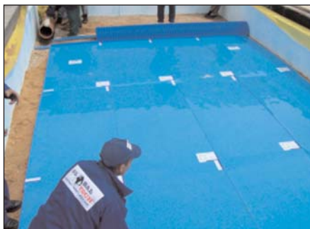
Fot. 8. 9 Nowatorskie zastosowanie wymiennika płytowego w fundamentach obiektu
