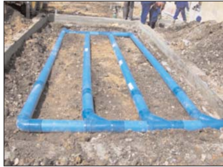
Fot. 4, 5 GWC w fundamentach
