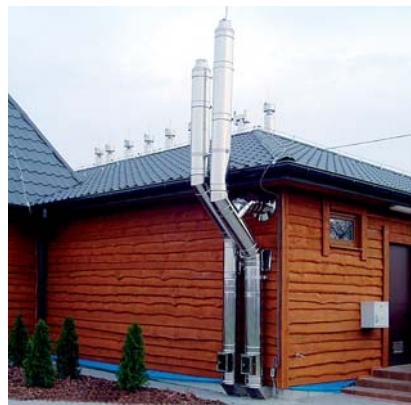
▲ Na zewnątrz budynku można zamontować komin dwuścienny
