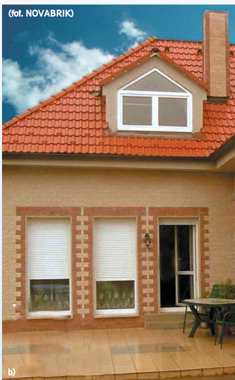
Płytki elewacyjne w różnych fakturach i kolorach mogą imitować np. cegłę (a) lub klinkier (b)
