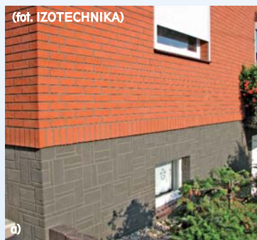
Płytki elewacyjne w różnych fakturach i kolorach mogą imitować np. cegłę (a) lub klinkier (b)
