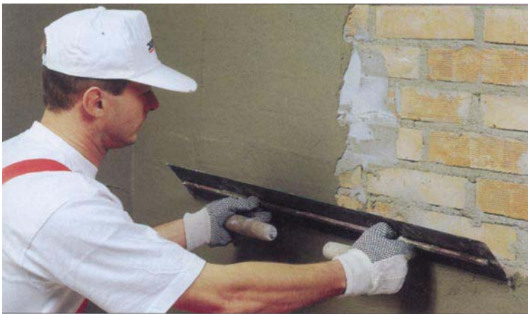
2 Nanoszenie narzutu długą pacą stalową (fot. maxit (dawniej Optiroc))
