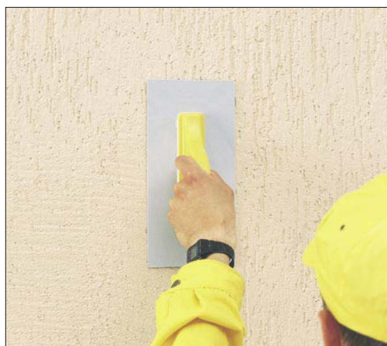
4 Przykład tynku ciągnionego o fakturze „kornikowej”: zależnie od kierunku ruchów pacy plastikowej można uzyskiwać pionowe, poziome lub koliste rysy pochodzące od ziaren zawartych w materiale (fot. Henkel Bautechnik)
