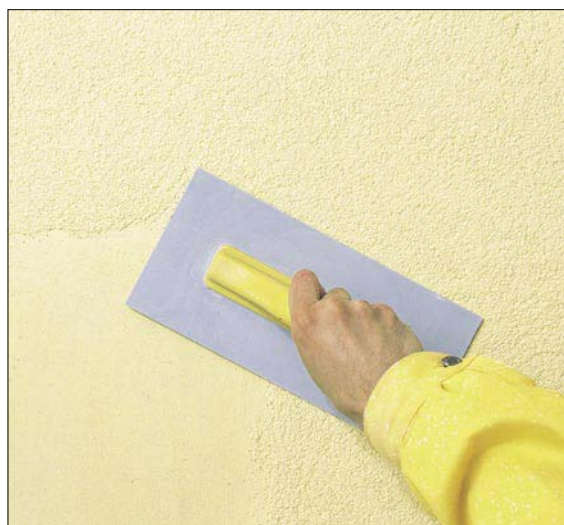
5 Tynk, zacierany plastikową pacą, uzyskuje wygląd gęsto ułożonych ziaren kruszywa; jest to faktura „kamyczkowa” (fot. Henkel Bautechnik)
