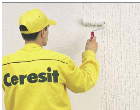
6 Fakturowanie tynku strukturalnego wałkiem (fot. Henkel Bautechnik)
