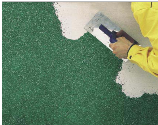
7 Nakładanie tynku mozaikowego (fot. Henkel Bautechnik)
