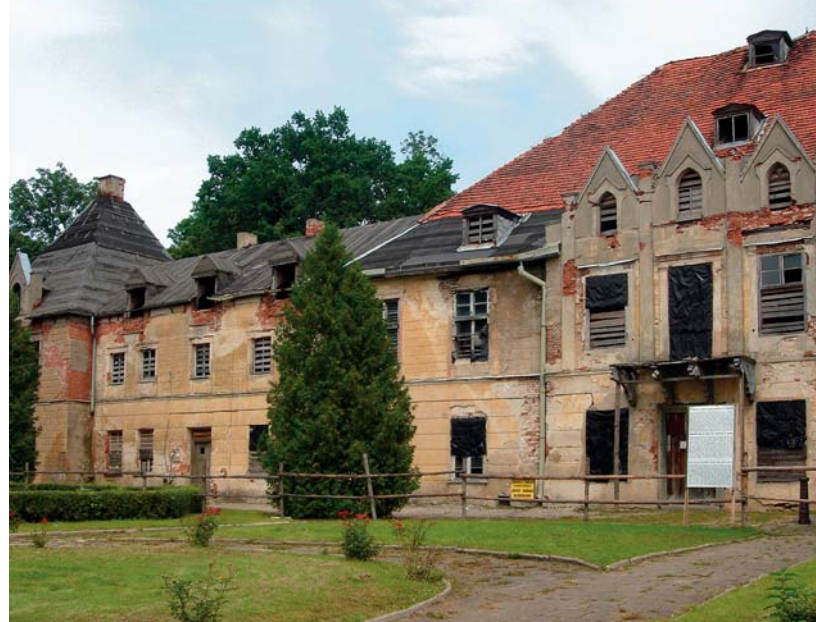
▲ Dach częściowo pokryty papą, częściowo dachówką, rozsypujące się pałacowe wnętrza – pałac w Sztynortcie to obraz nędzy i rozpaczy
