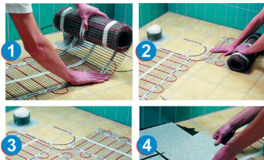
Etapy montażu maty grzejnej (fot. Danfoss)
