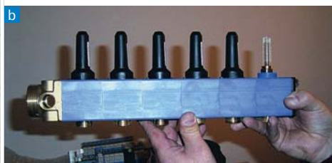
▲ Rozdzielacz zasilania z zamontowanym siłownikiem. Siłowników takich będzie w sumie 6. Ich zadaniem jest reagowanie na sygnały z czujników temperatury lub czujników punktu rosy i ewentualne zamykanie danego obiegu (a). Rozdzielacz powrotu z regulacją przepływu (b)
