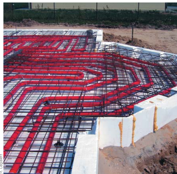
Fundament Legalett przed zabetonowaniem
