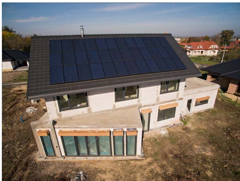
„Dom słoneczny” na etapie zakładania izolacji termicznej ścian. Źródło: Bison Energy
