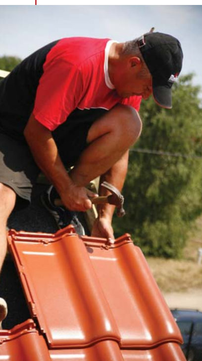
Dachówki brzegowe mocuje się bezpośrednio do łat
