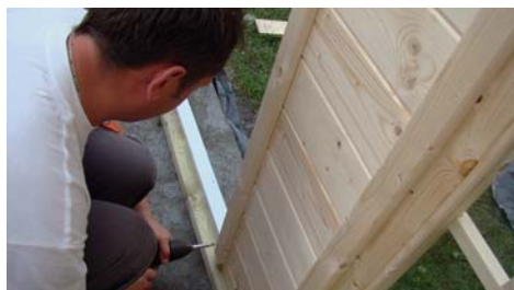
Montaż skręconej uprzędno futryny
