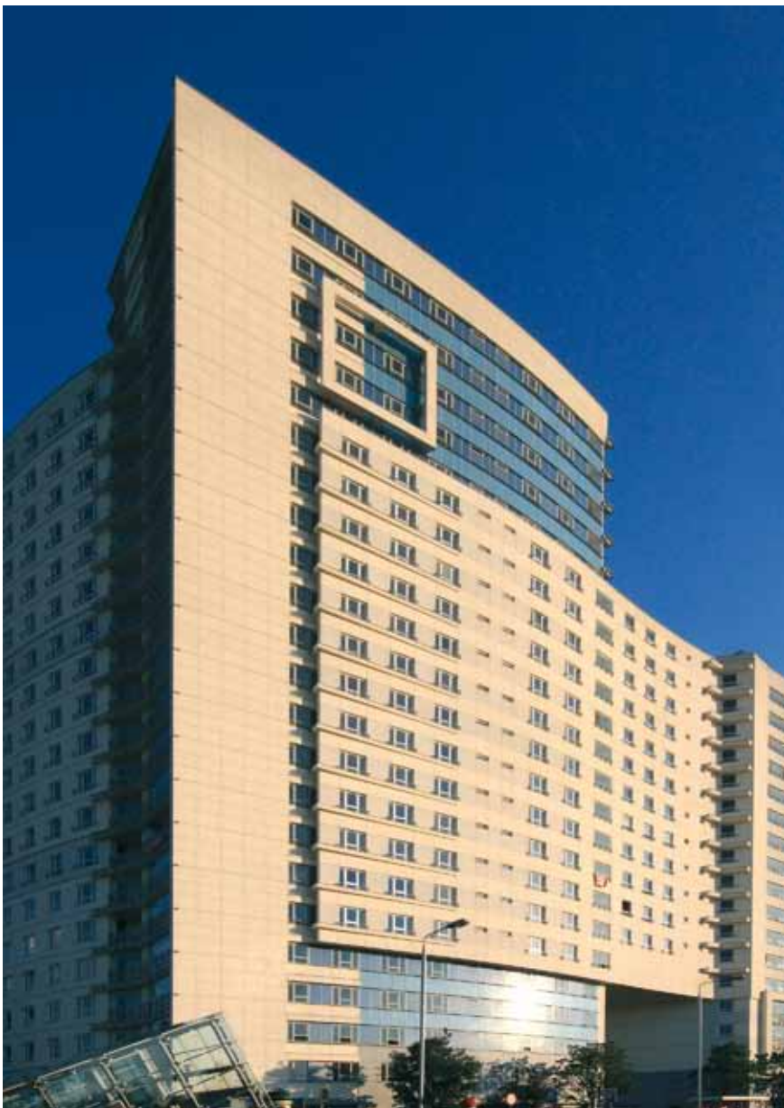
Powłoki pośrednie, np. StoPrep Miral, w znacznym stopniu poprawiają przyczepność, zapewniając w ten sposób dłuższą ochronę elewacji przed nadmiernym wchłanianiem wilgoci. (Pałac Schlossera, Ozorków; apartamentowiec Gdański, Warszawa)
