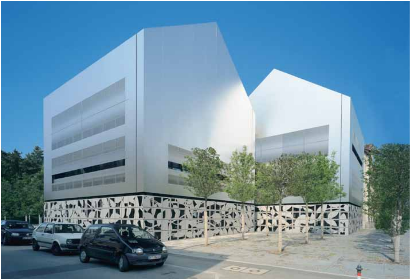
Przyszłościowo i wydajnie: trudno odgadnąć, że pod tą futurystyczną fasadą kryje się izolacja cieplna z wełny mineralnej StoTherm Mineral. (Südwestmetall Reutlingen, Niemcy)
