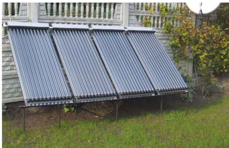
▲ Montując kolektor na dachu płaskim lub na ziemi, możemy optymalnie dobrać jego kąt nachylenia do powierzchni ziemi
