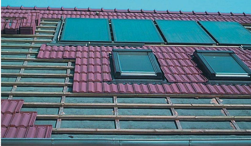
▲ W dach można wbudować jedynie kolektor płaski
