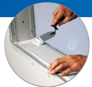
▲ Profile wzmacniające – sposób na uodpornienie krawędzi płyt na uszkodzenia
