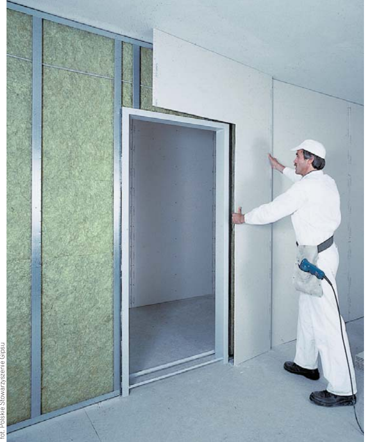
▲ Pokrywanie ścian szkieletowych płytami g-k. Długość płyt najlepiej dobrać do wysokości pomieszczeń. Wokół otworów drzwiowych płyty przycina się tak, by krawędź płyty nie pokrywała się z krawędzią ościeżnicy
