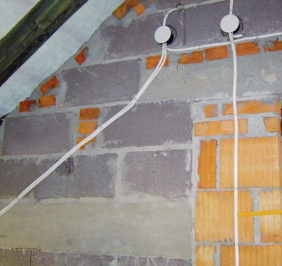
▲ Instalacje wtykowe mocuje się do ściany i przykrywa tynkiem
