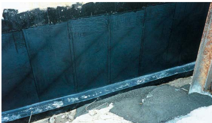
▲ Samoprzylepne materiały hydroizolacyjne są kosztowne, ale bardzo łatwe w użyciu i skuteczne, można z nich wykonać izolację przeciwwodną typu średniego
