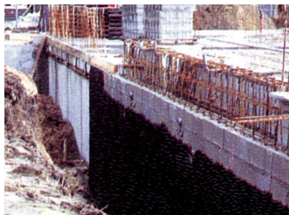
▲ Izolowanie ścian fundamentowych lepikiem asfaltowym do dziś jest najczęściej stosowanym rozwiązaniem
