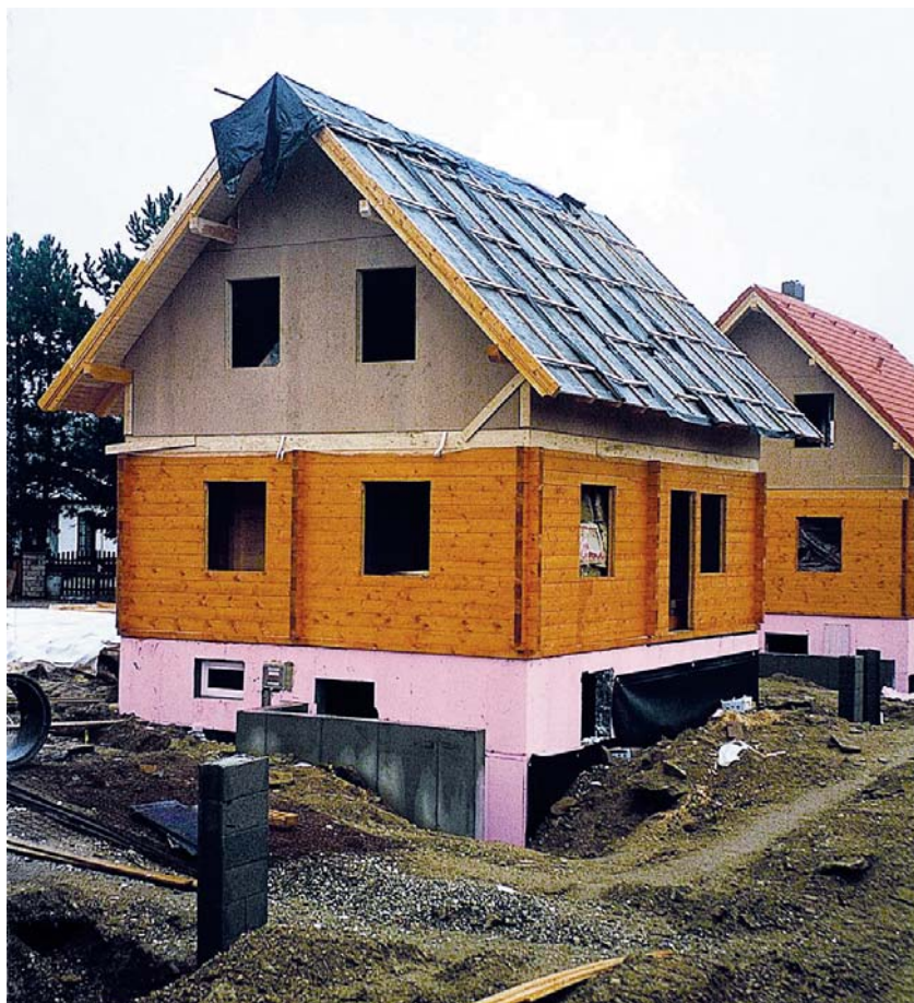
▲ Ściany piwniczne muszą być skutecznie zaizolowane pod względem termicznym i przeciwwilgociowym. Najlepszymi materiałami do tych celów są polistyren ekstrudowany i papa asfaltowa
