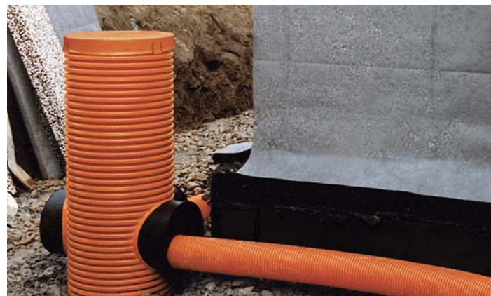
▲ Studzienki drenażowe powinny być ustawione na każdym załamaniu instalacji. Ułatwia to okresową inspekcję drożności rur i ewentualne ich czyszczenie
