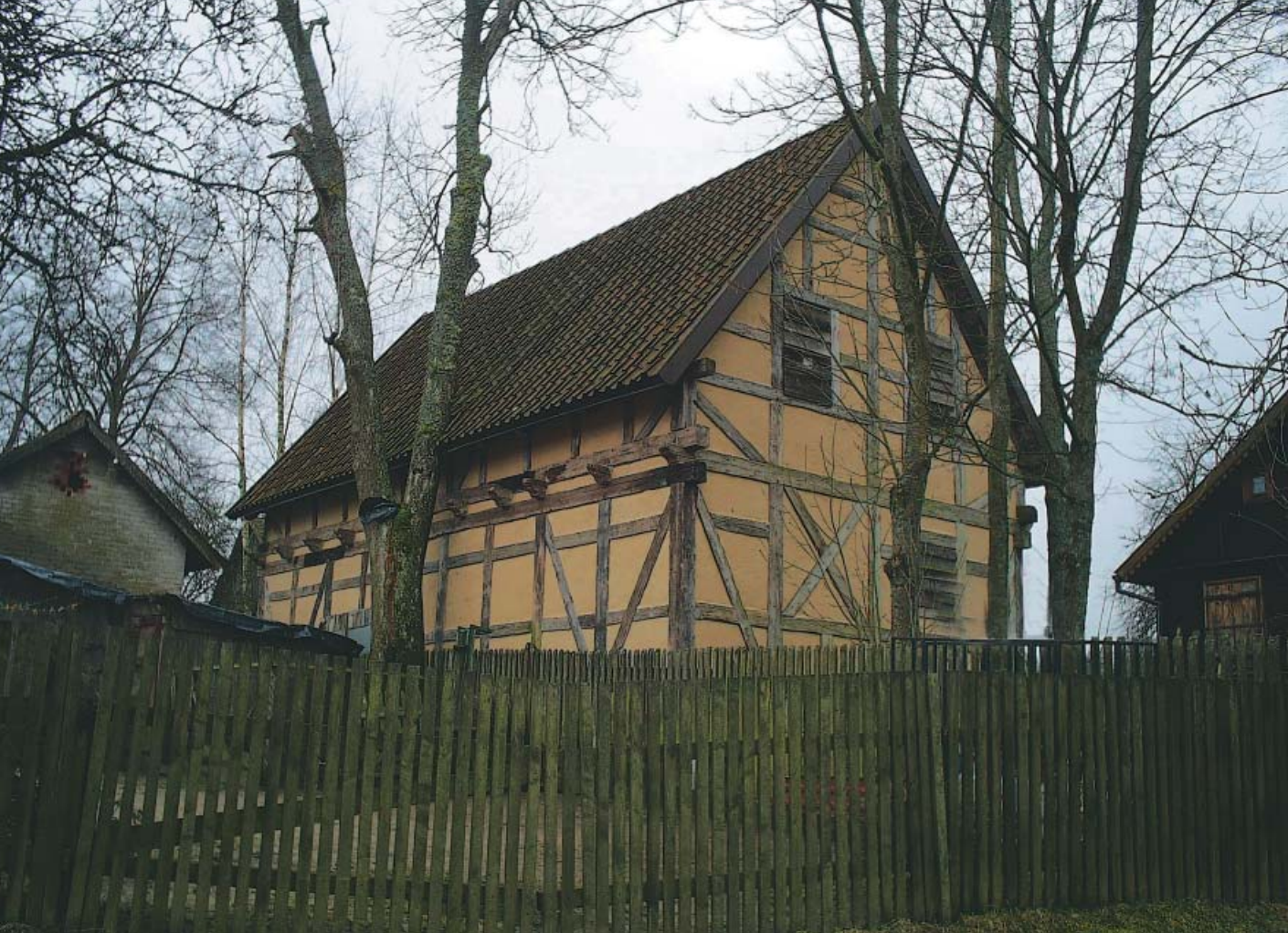
Dom o konstrukcji ryglowej powstający na Mazurach
