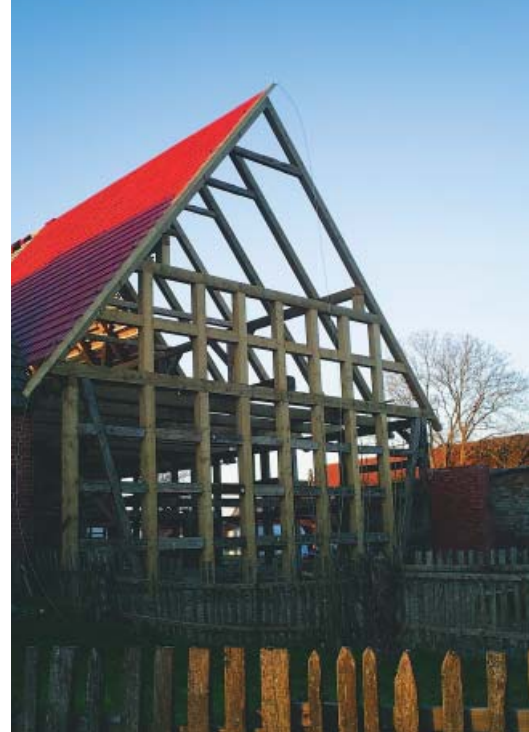
Szkielet odtwarzanego domu o konstrukcji szachulcowej; te ciemniejsze belki udało się zachować z dawnej budowli
