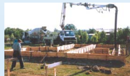
Wylewanie betonu dostarczonego „gruszką” (fot. archiwum BD)
