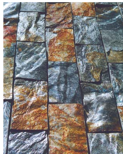
3 Nawierzchnia wykonana z dwóch rodzajów naturalnego łupka (fot. Jeleniogórskie Kopalnie Surowców Naturalnych) ▲
