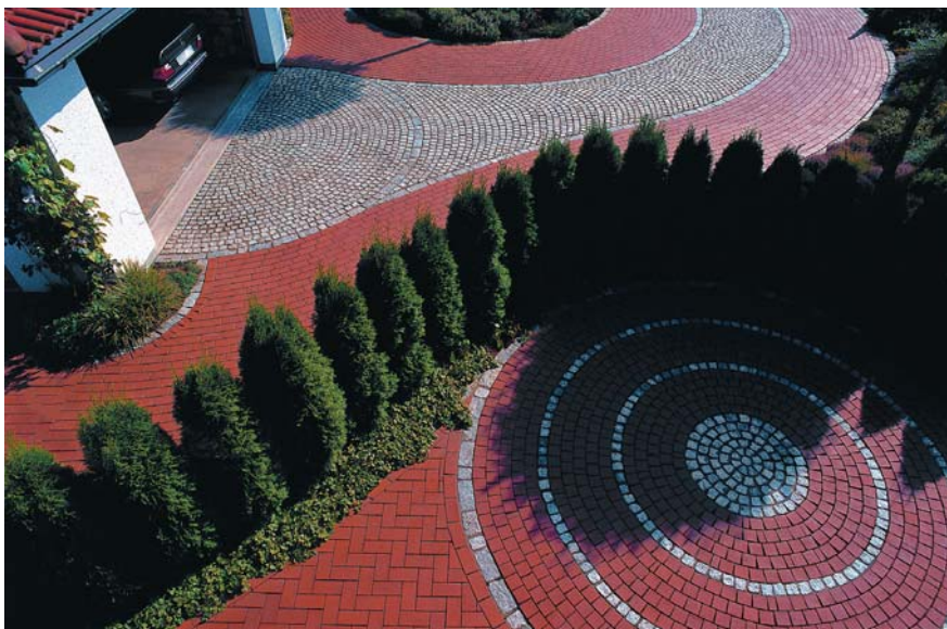
5 Elementy nawierzchniowe z klinkieru mogą mieć różny kształt; na zdjęciu widać połączenie prostokątnych cegieł z rozetą z kostki (fot. CRH Klinkier) ▼
