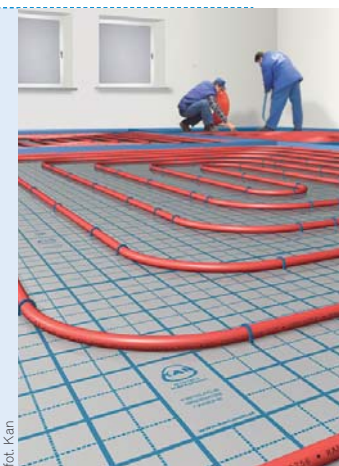
Kotły kondensacyjne najefektywniej współpracują z niskotemperaturowym ogrzewaniem podłogowym
