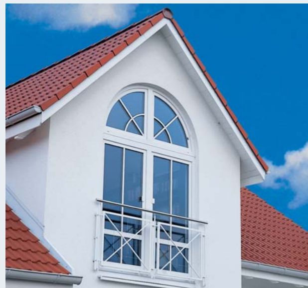
Lukarna jest elementem budynku, który trudno dobrze ocieplić. Warto więc rozważyć rezygnację z jej budowy i zdecydować się na tańsze i łatwiejsze w montażu okna dachowe
