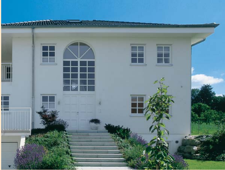
▲ Dwuskrzydłowe drzwi z ogromnym naświetlem są dobrym rozwiązaniem w domach z dużym holom wejściowym
